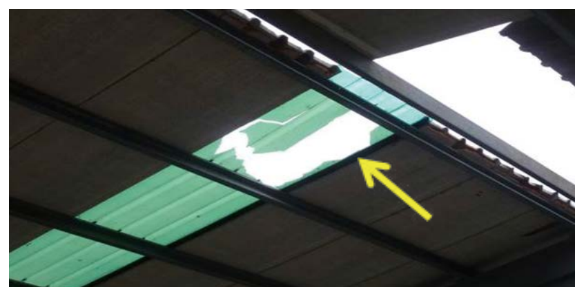
圖 5 踏破之採光罩開口處
