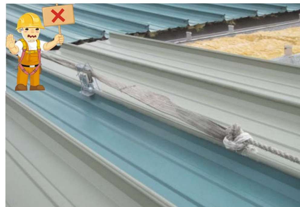
圖 53 設置之安全母索應為鋼索、尼龍繩索或合成纖維之材質，並不得使用綁紮方式進行連接
