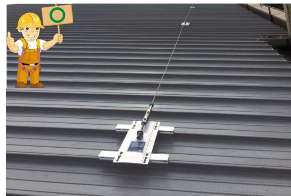
圖 54 (水平) 安全母索以鋼索材質設置，其最小斷裂強度應在 2,300 公斤以上
