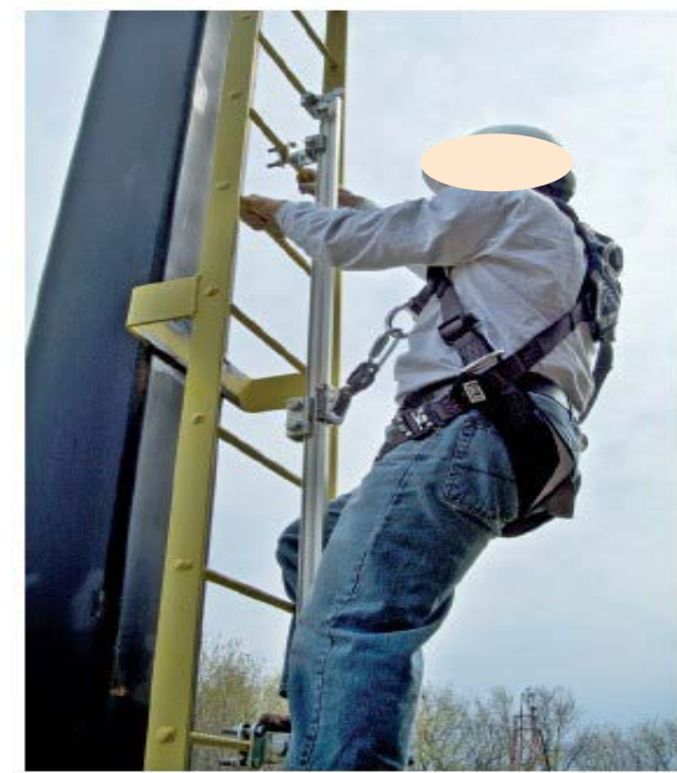
圖 32 設有垂直軌道系統之固定梯上下設備
