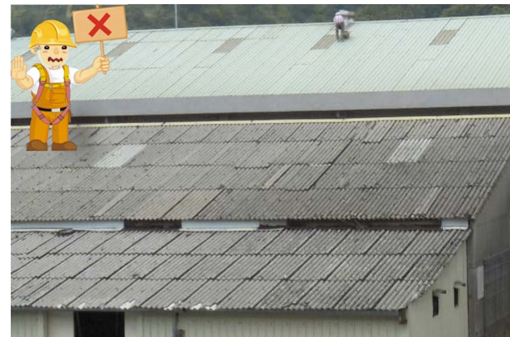
圖 49 於易踏穿材料構築及具傾斜面之屋頂作業時，未先規劃安全通道
