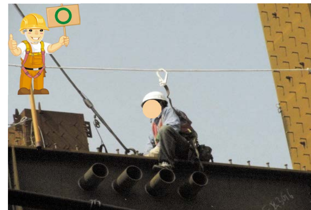
圖 42 勞工已確實配掛背負式安全帶並鉤掛於水平母索
