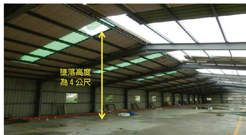
圖 4 廠房內高度實景
