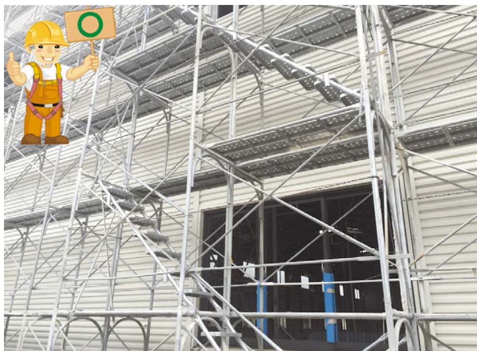
圖 40 高差超過 1.5 公尺以上之作業場所，設置使勞工安全上下之設備。(施工架樓梯)
