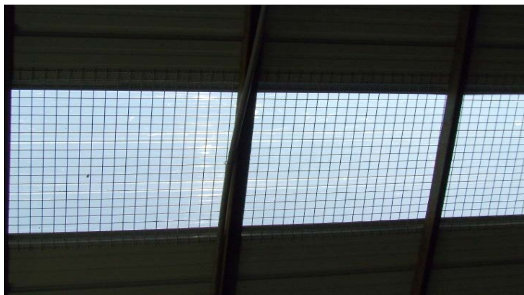
圖 36 廠房屋頂下方格柵網示意圖
