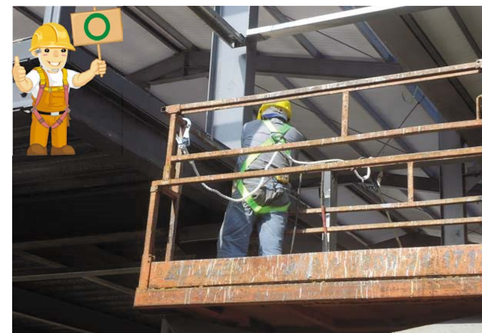
圖 46 於高空工作車之工作臺內實施作業，並確實佩戴安全帶及鈎掛堅固物件上
