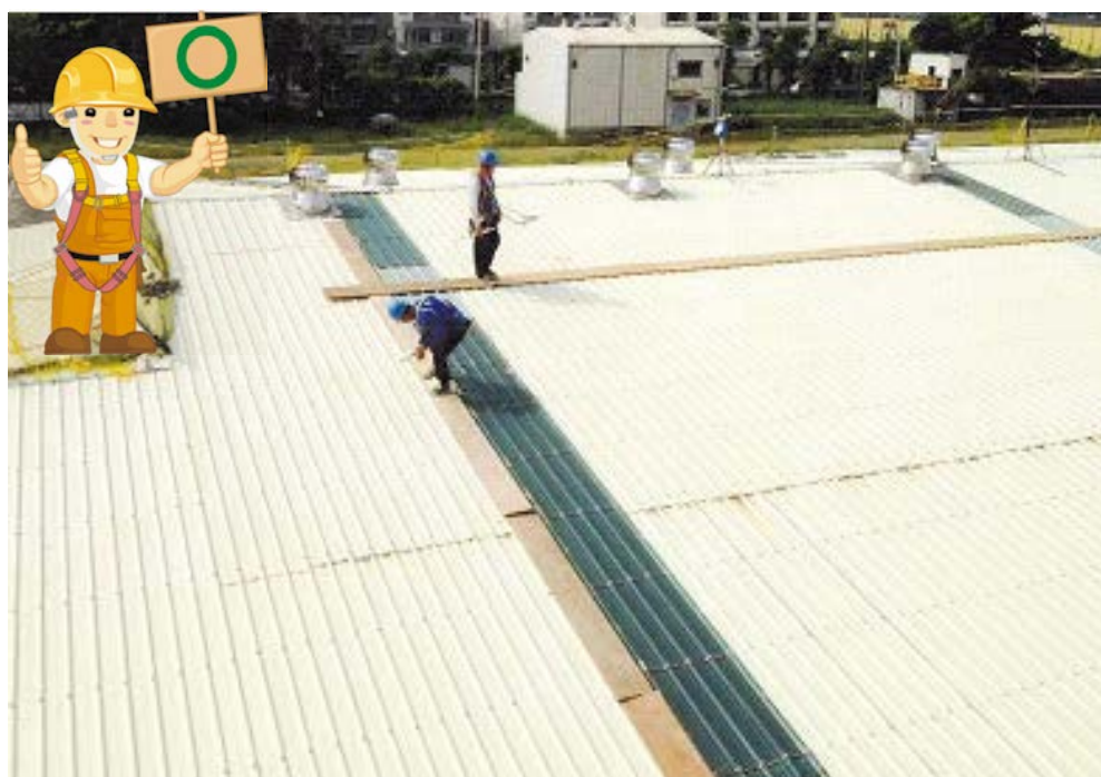
圖 48 設置之安全通道依營標第 18 條相關規定設置適當強度、寬度卅公分以上之踏板
